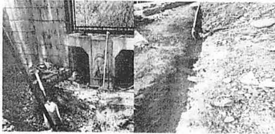
Foto 3: Demolición de inodoro ciego, reparación de muro perimetral existente inclinado
